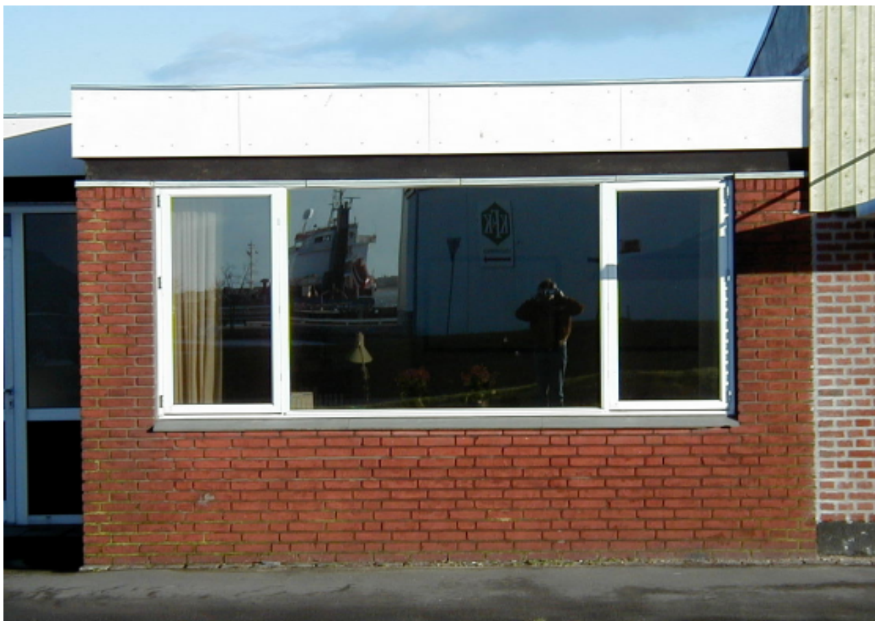
Udskifte vindue ved rundkørsel på H.E.Blumesvej
